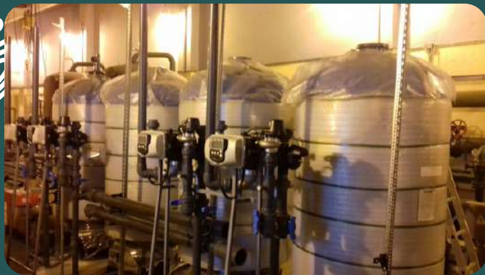
Металлургический завод г.Выкса
